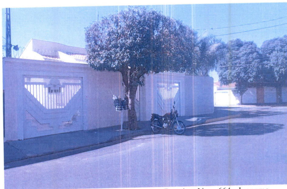
Localização SRT Casa das Violetas: Rua Ana Nery 664 - Ipanema
